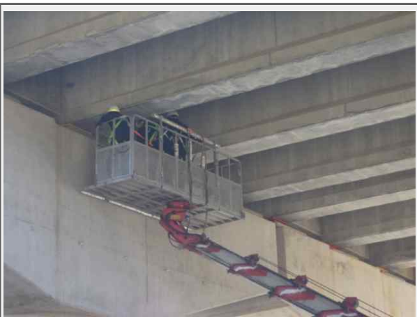
내 용 내포교(영천) 교각 보수
