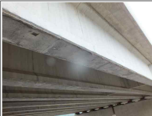
내 용 내포교(영천) 거더
