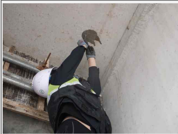
상부구조 탄산화깊이 측정
