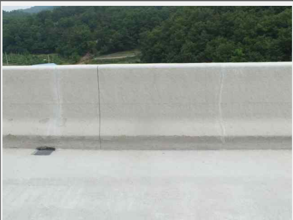
내 용 내포교(영천) 방호벽 보수
