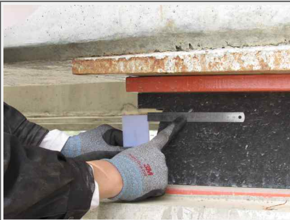
A1 교량반침 이동량 측정(상주)
