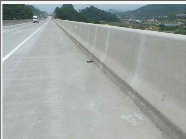
내 용 내포교(상주) 방호벽 보수
