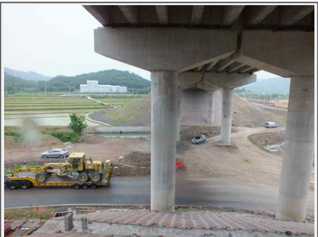
내 용 내포교(상주) 교각
