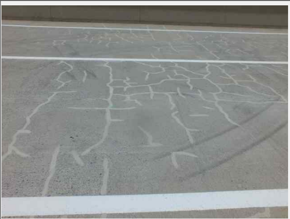
내 용 내포교(영천) 교면포장 보수
