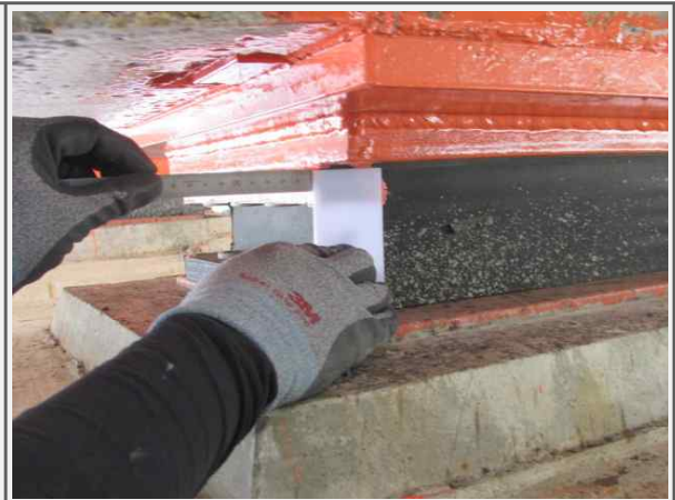
P3 교량반침 이동량 측정(상주)
