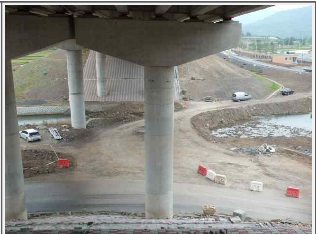
내 용 내포교(영천) 교각
