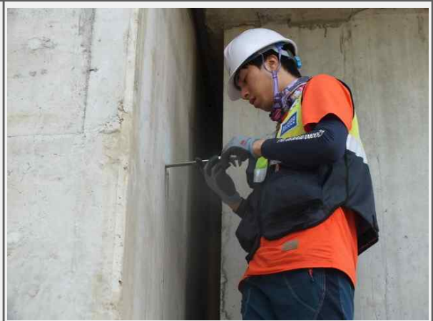
하부구조 탄산화깊이 측정
