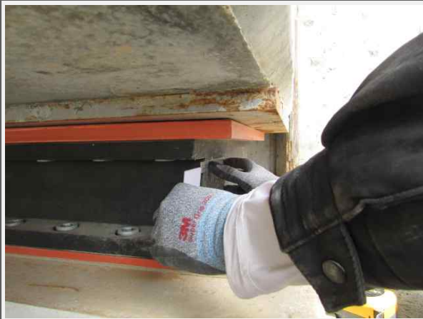
A1 교량반침 이동량 측정(영천)
