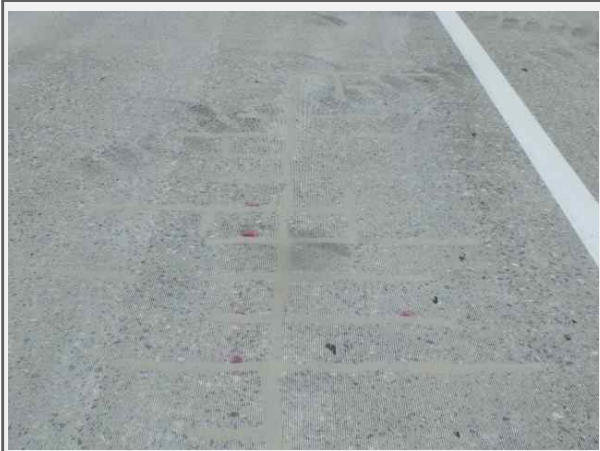
내 용 내포교(상주) 교면포장 보수
